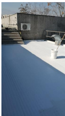
Mantenimiento techumbre Sede Sur M$ 3.523
