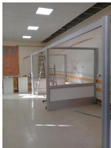
Adecuación salas hospitalizado 11 y 15 M$ 56.985
