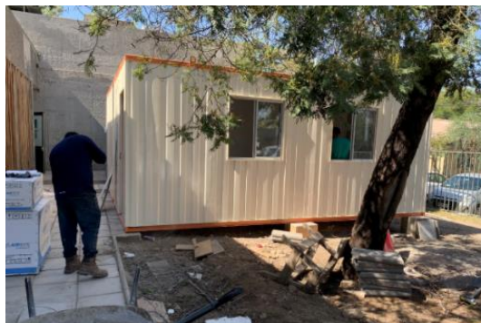
Instalación de modulares Sede Sur M$ 28.025
