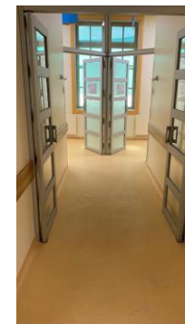
Adecuaciones salas de neutropénicos M$ 13.913
